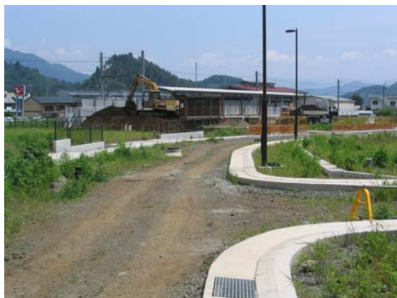
(建設中の新駅 2004年6月24日撮影)
